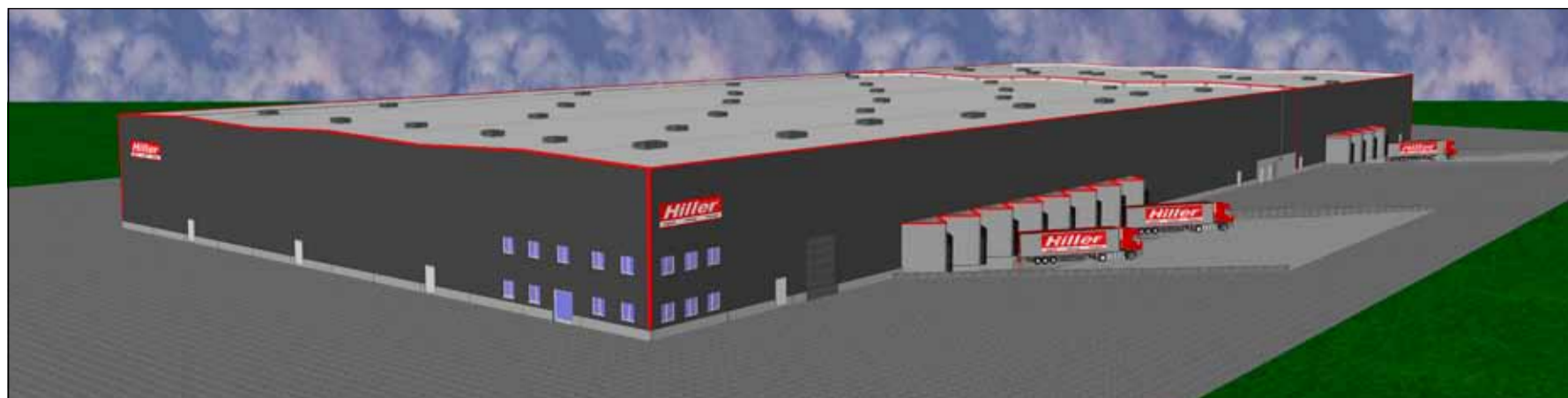
Mit 15.000 Quadratmetern Grundfläche verfügt die Firma Hiller Logistik ab 2017 über eine der größten Logistikimmobilien in der Region.
