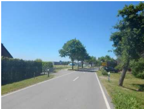
Abb. 1 Ortsdurchfahrt Garlstorf (K4)
