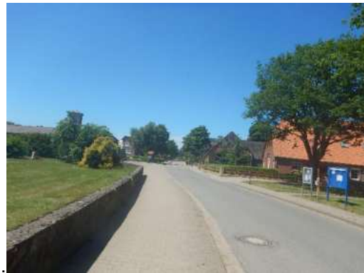
Abb. 2 Ortsdurchfahrt Garlstorf (K4)
