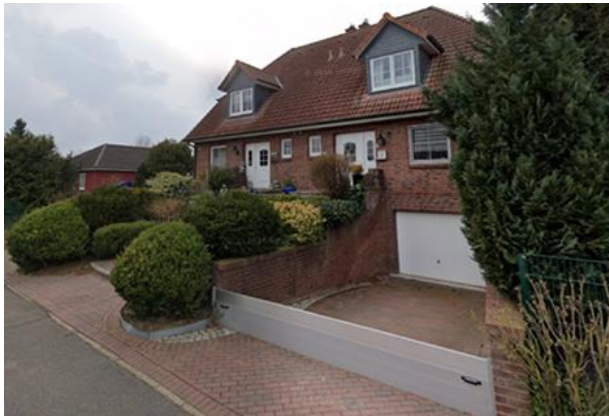
Abb. 14: Fluttor zum Schutz einer Tiefgarage in Alt Garge, Am Feldrain 4
