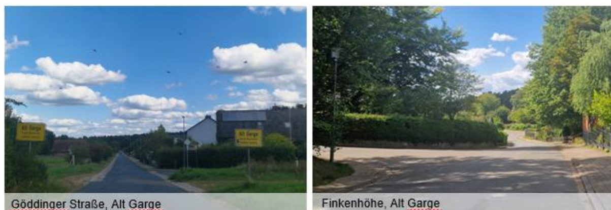
Abb. 12: Beispiele für unzureichende Oberflächenentwässerung im Ortsteil Alt Garge
