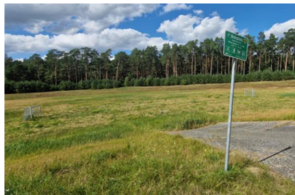
Abb. 17: Multifunktionales Regenrückhaltebecken an der Stiepeler Straße, Alt Garge
