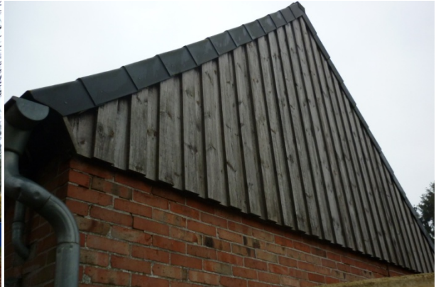
Abb. 2: Nebengebäude, Westfassade mit Holzverschalung.
