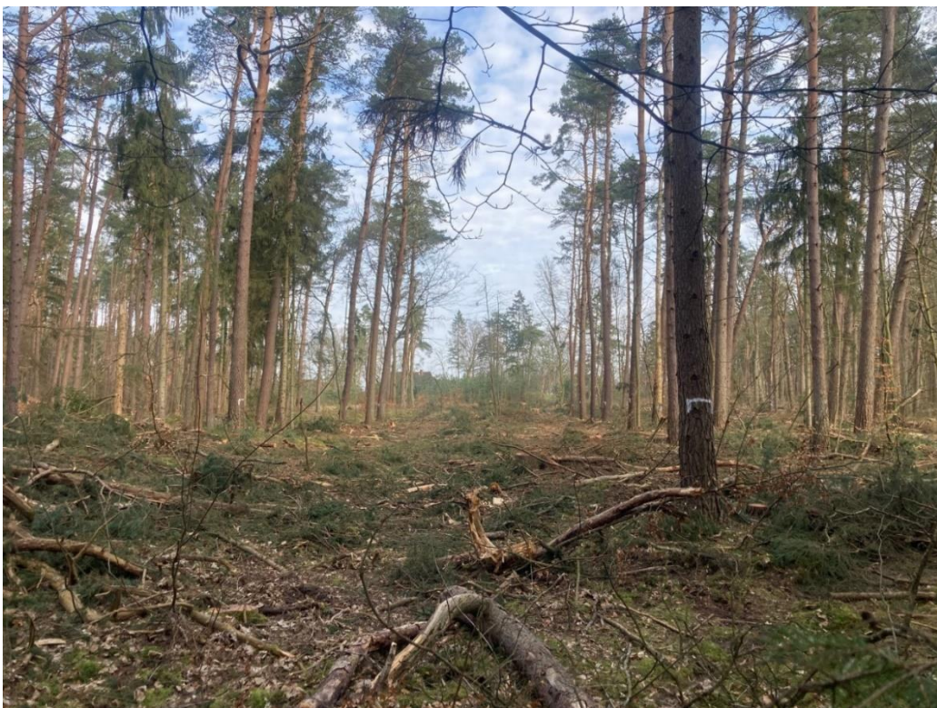
Abb. 15 Aufhieb der unterirdisch verlaufenden historischen Ölleitung im Nord-Süd Verlauf
